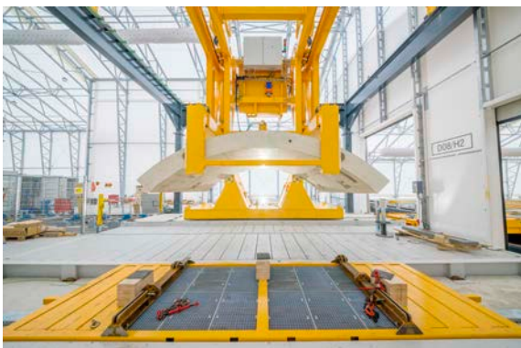
Das Herzstück der Anlage: Die CNC-Betonschleifanlage Bildquelle: Max Bögl Wind AG/Reinhard Mederer
