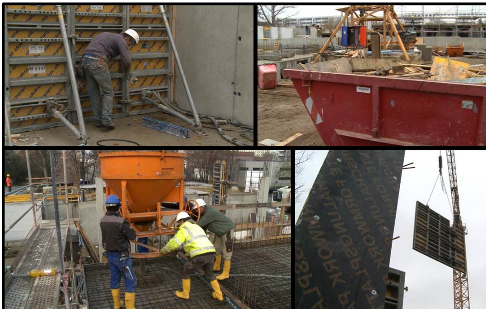
Bild 1: Konventionelle Ortbetonbauweise mit Schalungssystemen
